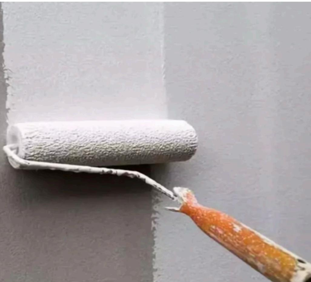
防火涂料本身是不可燃的，涂刷在墙体表面可有效隔绝空气，防止被保护的基材直接接触空气，延迟物体的爆燃，降低燃烧速度。
